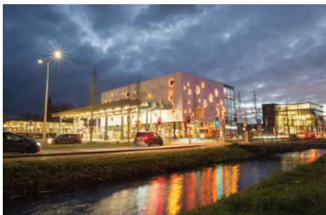
Obchodní centrum a kancelářské budovy
